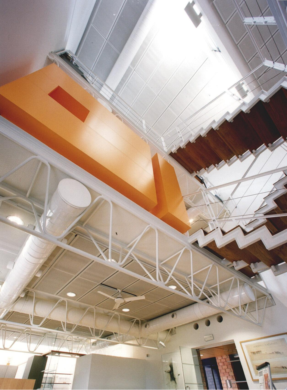
Κτήριο γραφείων, Πολύδροσο
