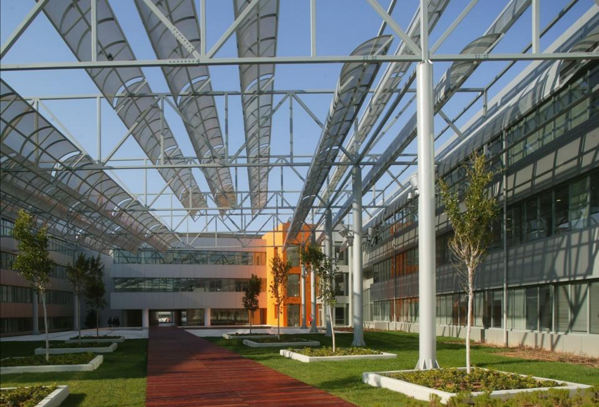
Κτήριο Γραφείων της εταιρείας Καλυφτάκι Α.Ε. Κάτω Κηφισιά, Αθήνα
